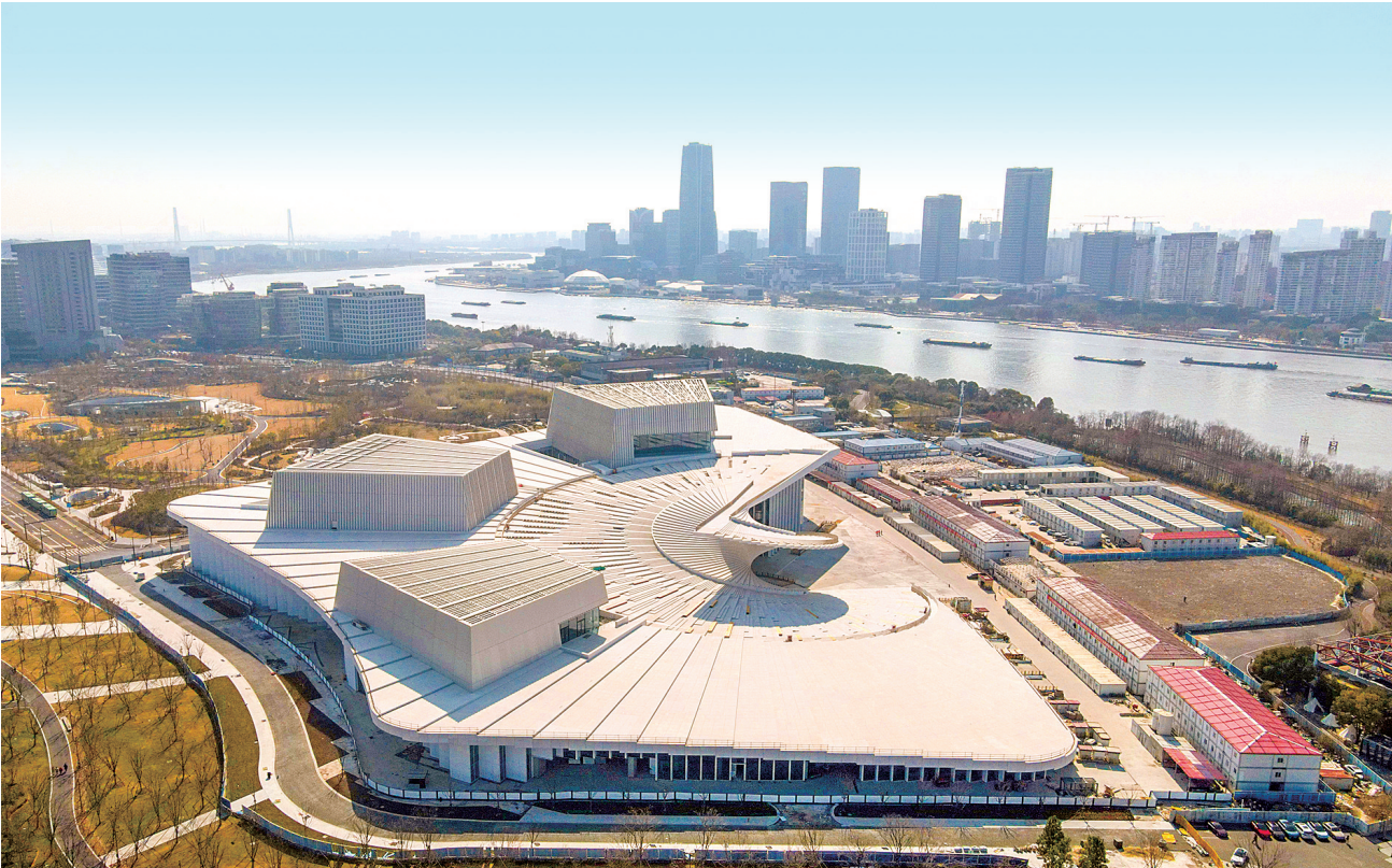
近日，位于浦东世博文化公园内的上海大歌剧院建筑主体施工完成，建筑外形恰似打开的“中国扇”。
