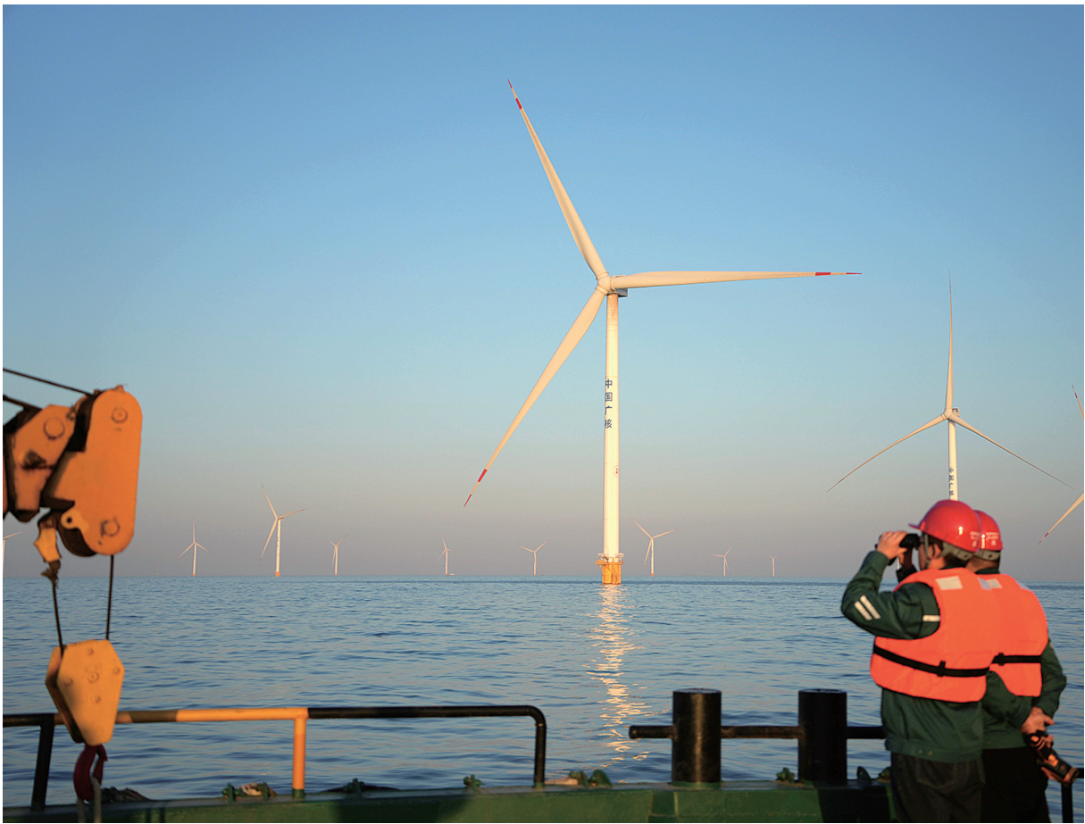
在全球能源加速向低碳转型的背景下,我国新能源产业成为绿色发展的一抹亮色。图为在山东省莱州市海上风电项目海域,国网莱州市供电公司的工作人员开展巡查工作。
