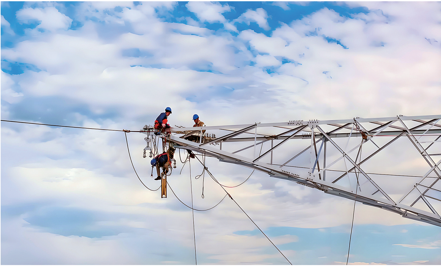
于2024年底建成投运的哈密—重庆±800千伏直流特高压输电线路,是我国“西电东送”重点工程,线路总长约2300千米,穿越甘肃、陕西、四川等5个省市区。图为甘肃省张掖市甘州区2017号铁塔上,电力工人正在进行架线、安装作业。
