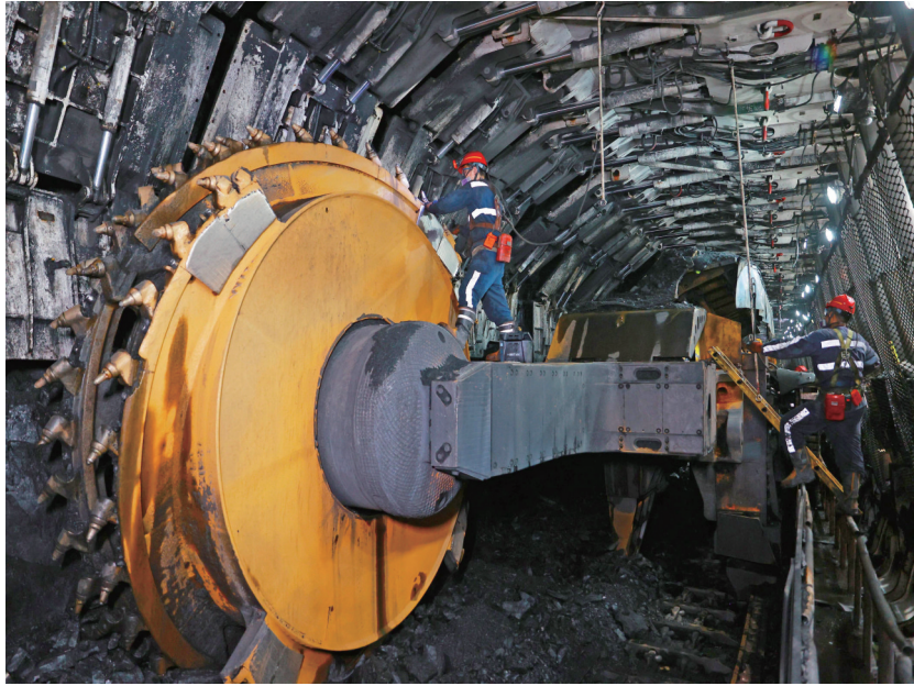
检修工正在更换采煤机截齿,确保设备高效稳定运行。
