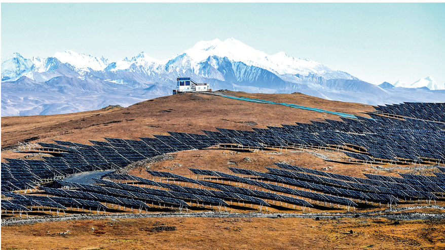
近日,“万千气象看四川”四季度集中采访活动走进甘孜州道孚县,了解亚日光伏项目建设情况。
