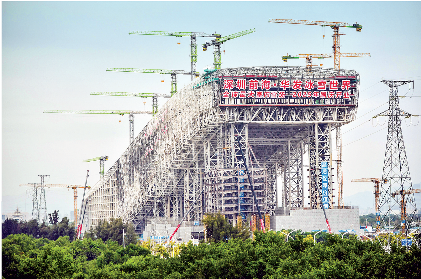
由中建三局承建的深圳前海华发冰雪世界项目,目前主体结构全面封顶,已进入装饰装修阶段。该项目雪场部分系粤港澳大湾区最大室内滑雪场,将于2025年建成对外开放。图为前海华发冰雪世界项目主体结构。
