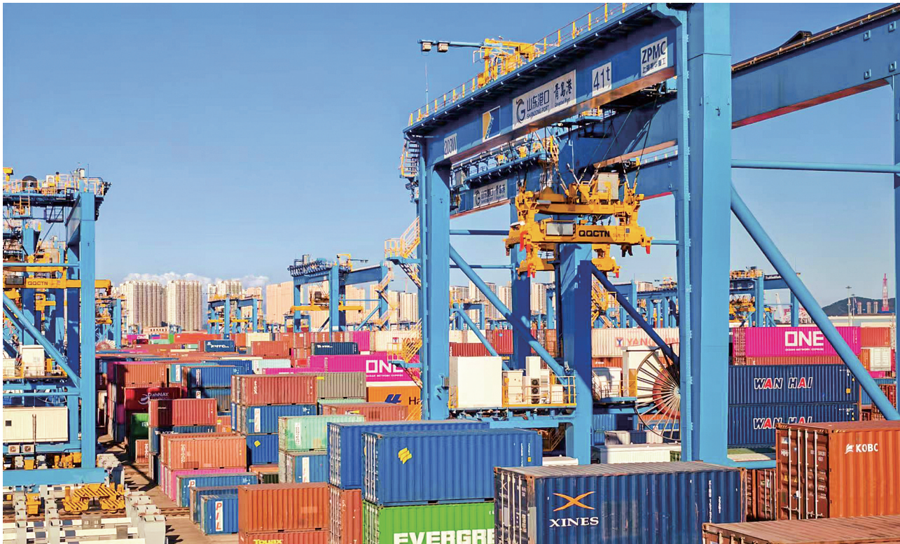
山东港口集团青岛港全自动化集装箱码头，桥吊正在自动抓起、堆码集装箱。
