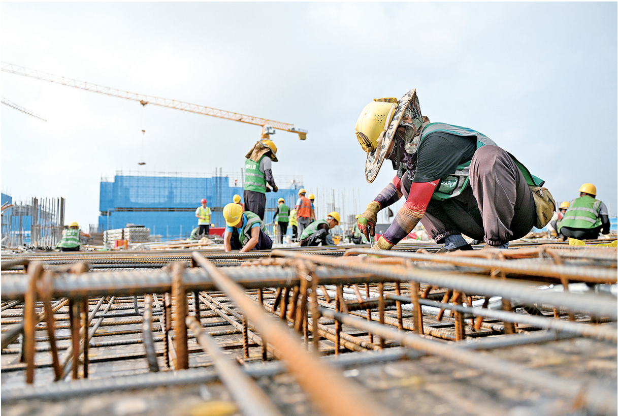
随着城市建设的快速发展,工业活动、商业活动、建筑施工活动频繁,导致噪声源增多。图为工人在施工作业。
