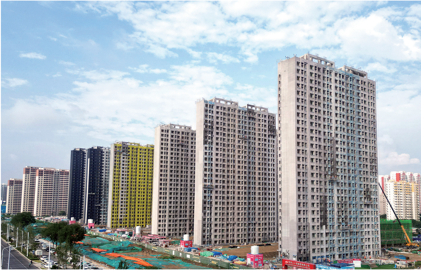
近日,由中铁二十局承建的河北省保定市城中村改造三期工程南刘各庄村安置区项目建设,正在按照节点要求扎实推进。图为项目建设工地。
