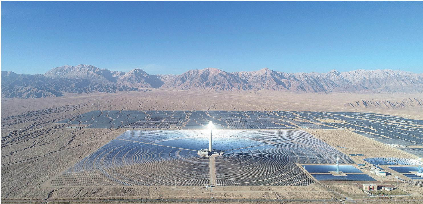
青海中控德令哈50MW塔式熔盐光热发电项目
