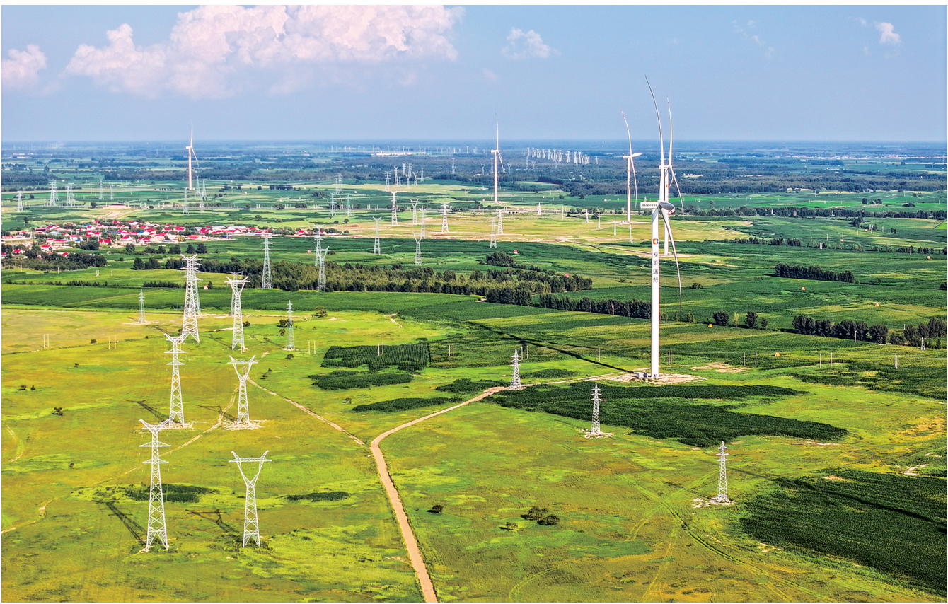
近年来,东北地区围绕资源优势加速布局清洁能源产业,持续加快风能、光能、氢能等新能源产业建设,为全面振兴提供新动能。图为内蒙古自治区通辽市238万千瓦风电项目。
