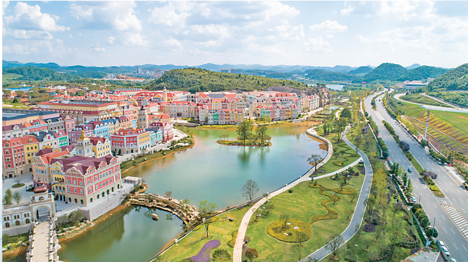
华为贵安数据中心
