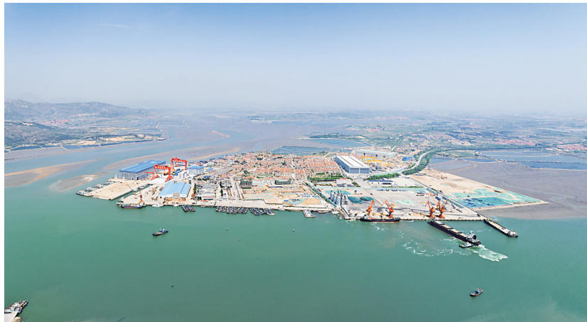
乳山海上风电装备制造产业基地
