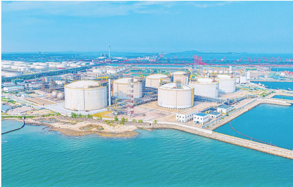
国内容积最大、首座完工的超大型液化天然气(LNG)储罐于2023年8月在山东省青岛市建成。该项目由中国石化自主研发了27万立方米全容式LNG储罐成套技术。(中国石化供图)
