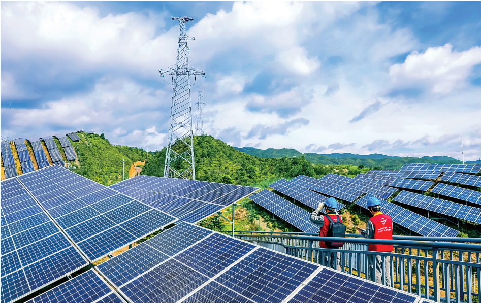
2024年7月4日,国网泰顺县供电公司员工在浙江省温州市泰顺县西阳镇对兴农光伏电站线路开展特巡。
