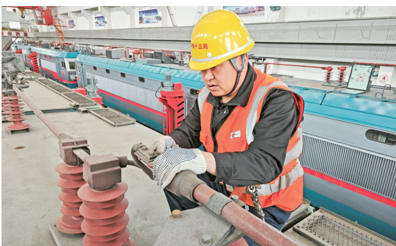
6月25日,陕西省神木市中铁十五局轨道运营公司包神铁路运输处检修大修库内,工作人员在更换机车车顶超限软编线。该运输处通过细化检修精细化管理工作,保障煤炭运输安全,夯实迎峰度夏优质电力保障。
