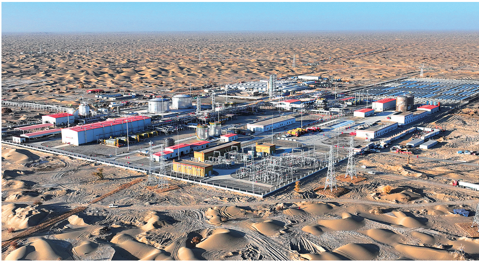
茫茫沙海中崛起一座现代化油气处理场站 (中国石油塔里木油田公司供图)
