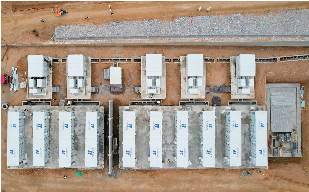
目前,位于河北省平山县的“平山西柏坡百兆瓦级新型电力系统示范工程”建设正按照工程建设节点要求稳步推进。该项目为国家级新型储能试点示范项目,建成投运后,将通过储能设备削峰填谷,全面提升区域电网内的光伏消纳能力,为当地经济发展提供可靠绿色电能。图为工人在该项目建设工地施工。
