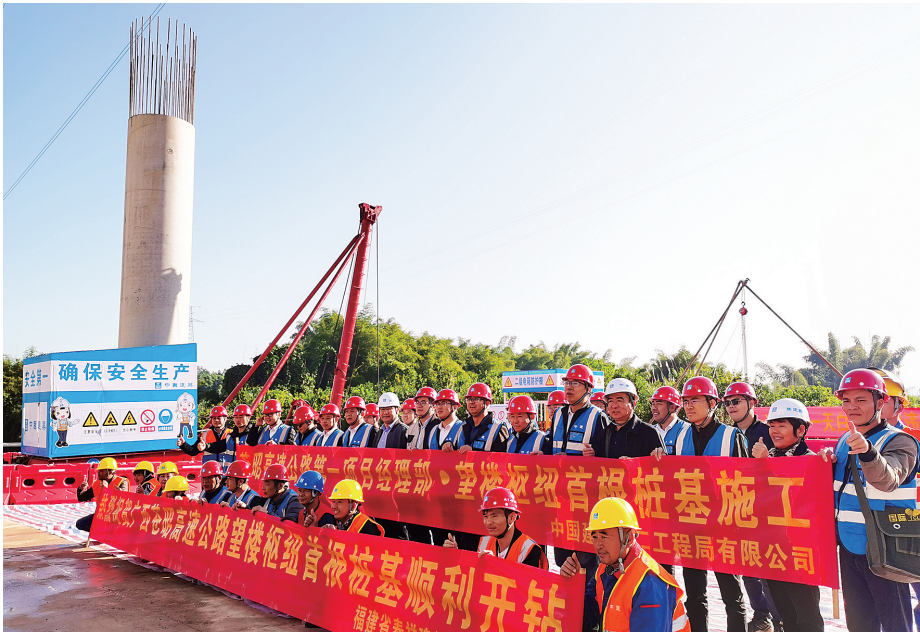
福建省泰祥建筑劳务有限公司参建的苍昭高速全线首根桩基顺利开钻
