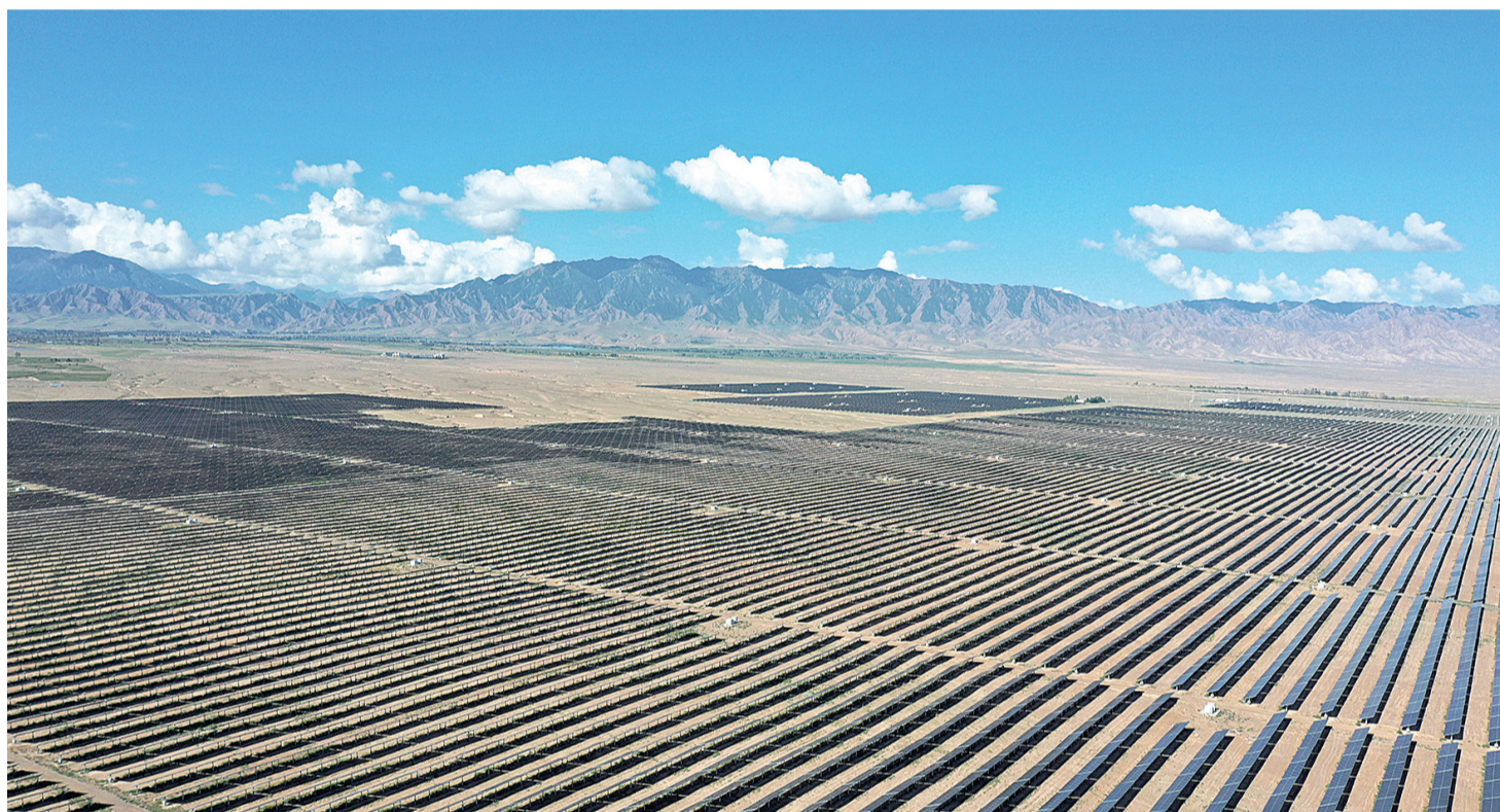
图为中国能建张掖甘州南滩30万千瓦光伏发电项目。
