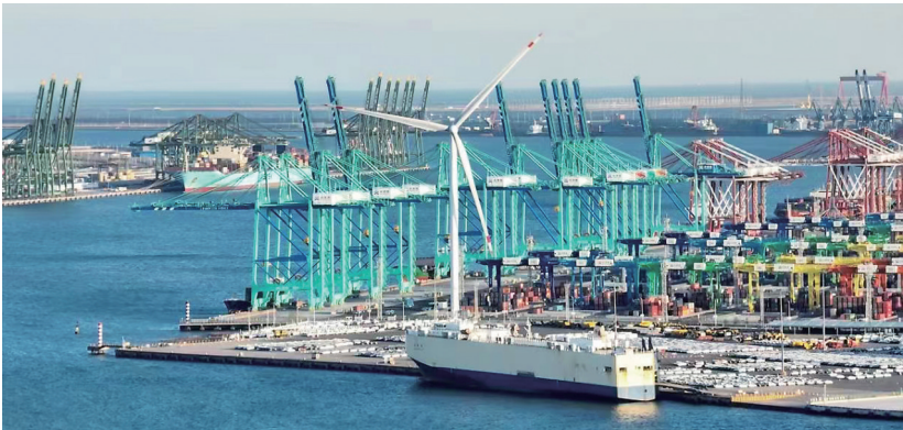
全球首个“智慧零碳”码头——天津港北疆港区C段智能化集装箱码头
