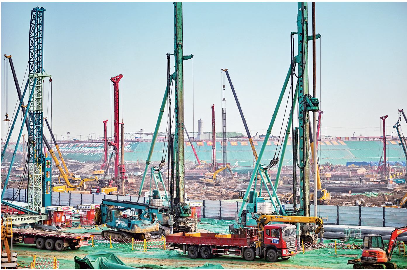
目前,雄安新区进入大规模建设与承接北京非首都功能疏解并重阶段,工作重心转向高质量建设、高水平管理、高质量疏解发展并举。时下,雄安新区启动区内重点项目建设稳步推进。图为雄安新区东西轴线项目片区建设现场。 新华社记者 牟宇 摄
