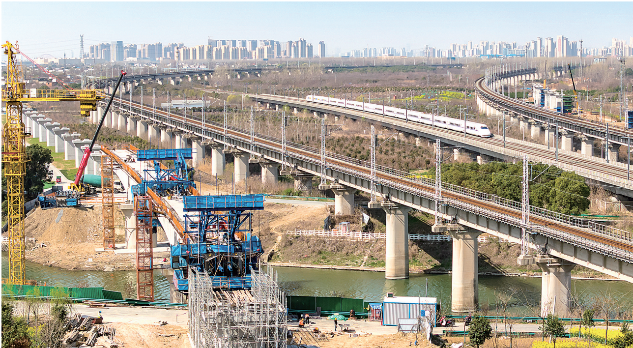
连日来,位于安徽省合肥市的新建上海至南京至合肥高速铁路施工现场一派繁忙。新建上海至南京至合肥高速铁路是国家中长期铁路网规划“八纵八横”中沿江通道的重要组成部分。
