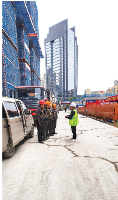
永嘉县住建局指导上塘滨江一号建筑工地进行岗前安全教育(一)
