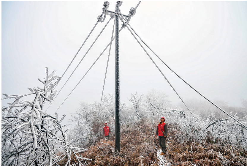
国网常德壶瓶山供电所东方红(电骡子)共产党员服务队队员对10千伏果峰线北山支线进行巡视,检查防冰拉线,变压器,清理通道树竹。
