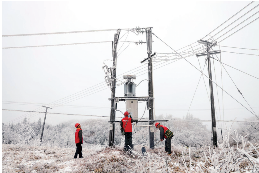
国网常德壶瓶山供电所东方红(电骡子)共产党员服务队队员对10千伏果峰线北山支线进行巡视,检查防冰拉线,变压器,清理通道树竹。
