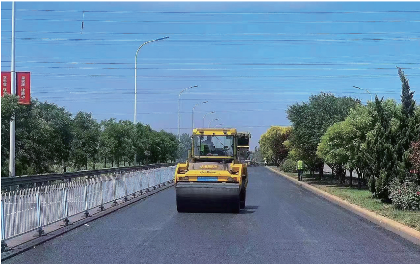
铺好的沥青路面
