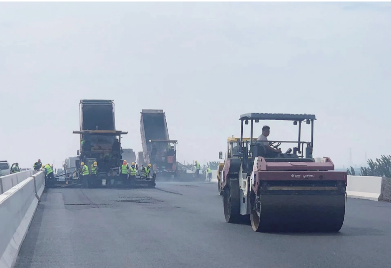
在建的高速公路
