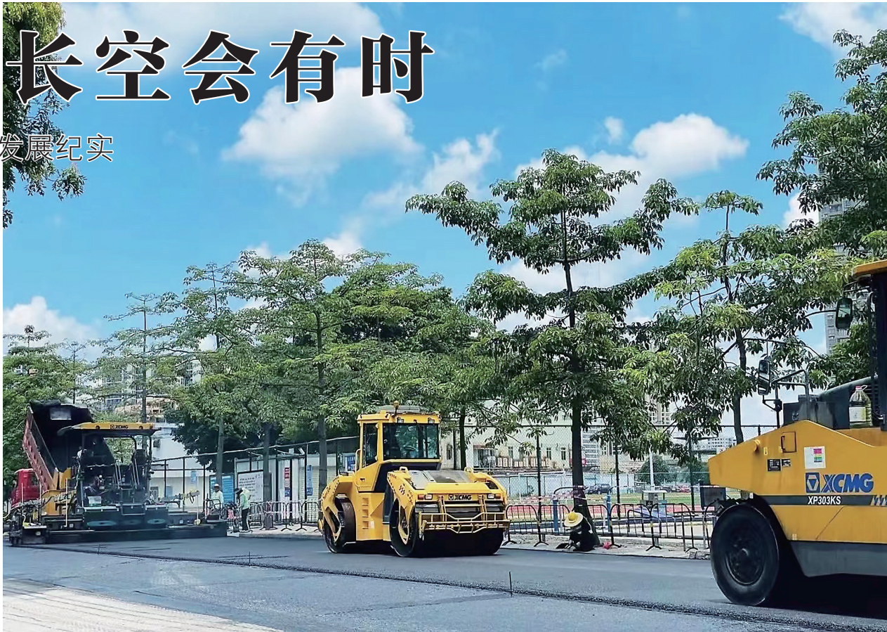
正铺的沥青市政大道
