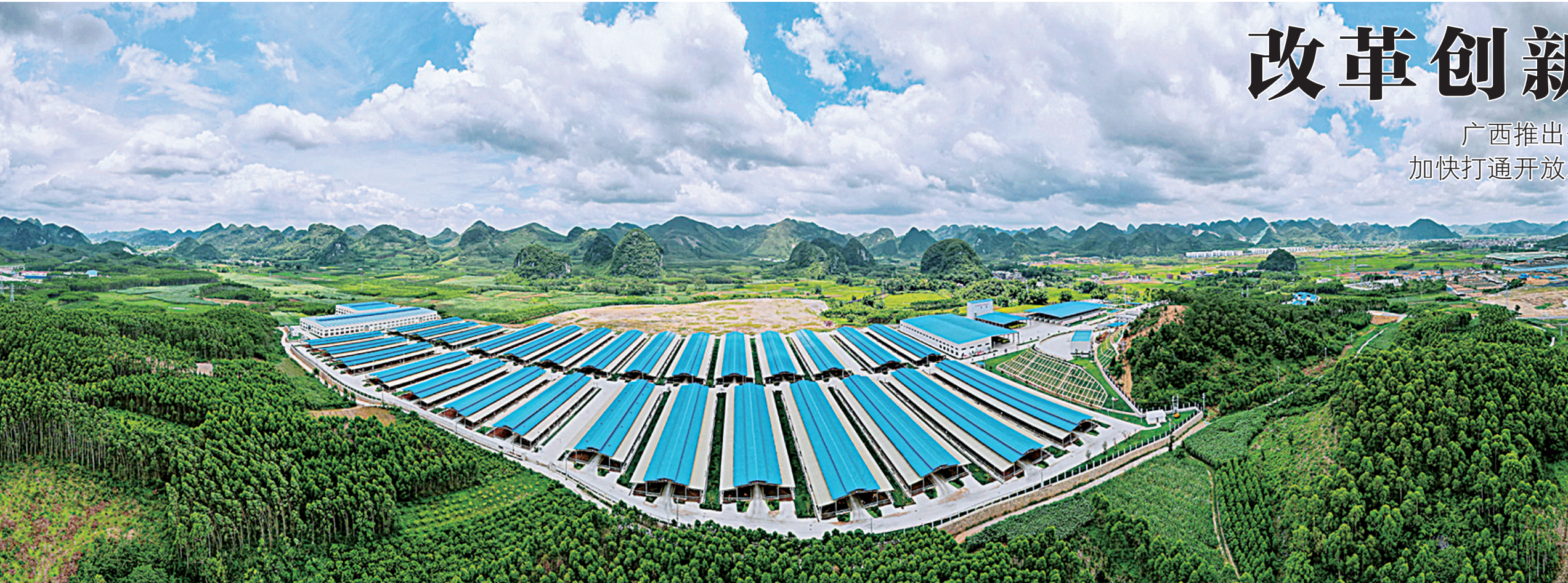
忻城县“南方牛都”全产业链项目全景
