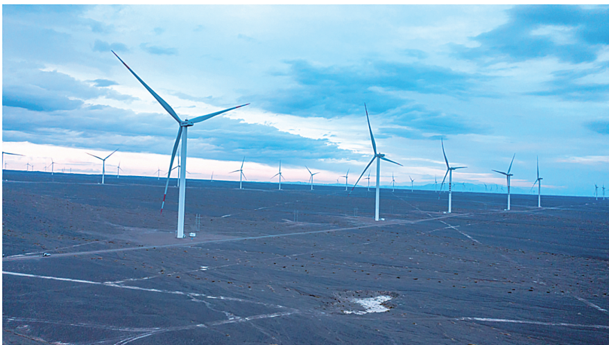
新疆维吾尔自治区哈密市风储一体化项目
