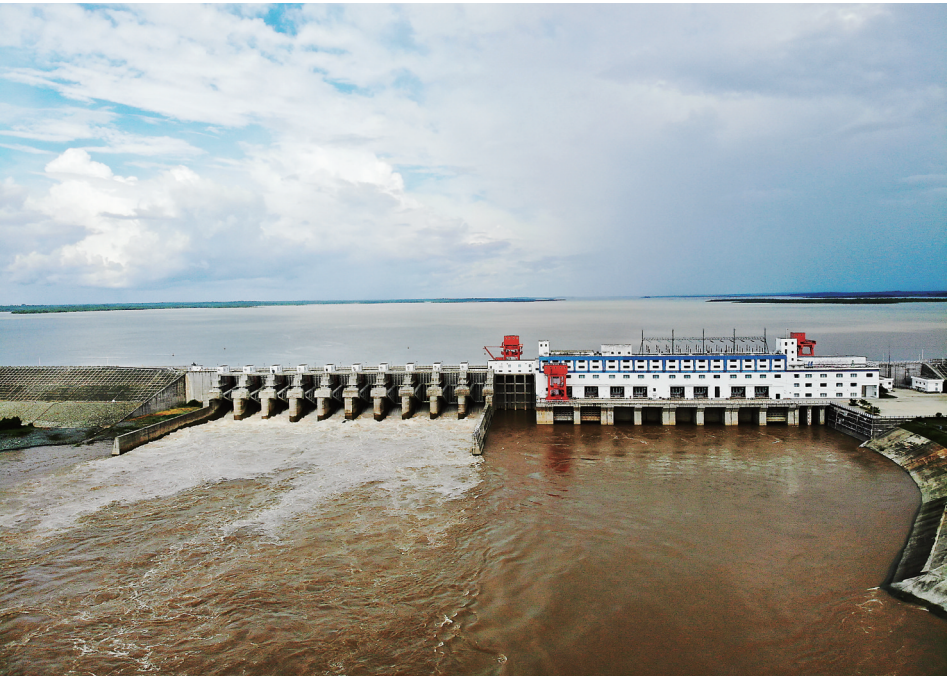
桑河二级水电站位于柬埔寨东北部上丁省西山区境内的桑河干流上,由中国华能建设运营,占柬埔寨全国总发电装机容量的近20%。
