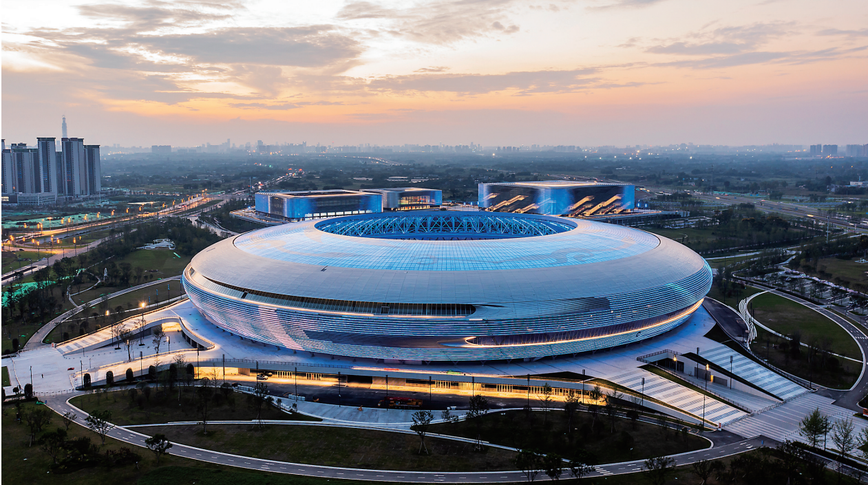
东安湖体育公园(世界大运公园)主体育场 (未来影像供图)
