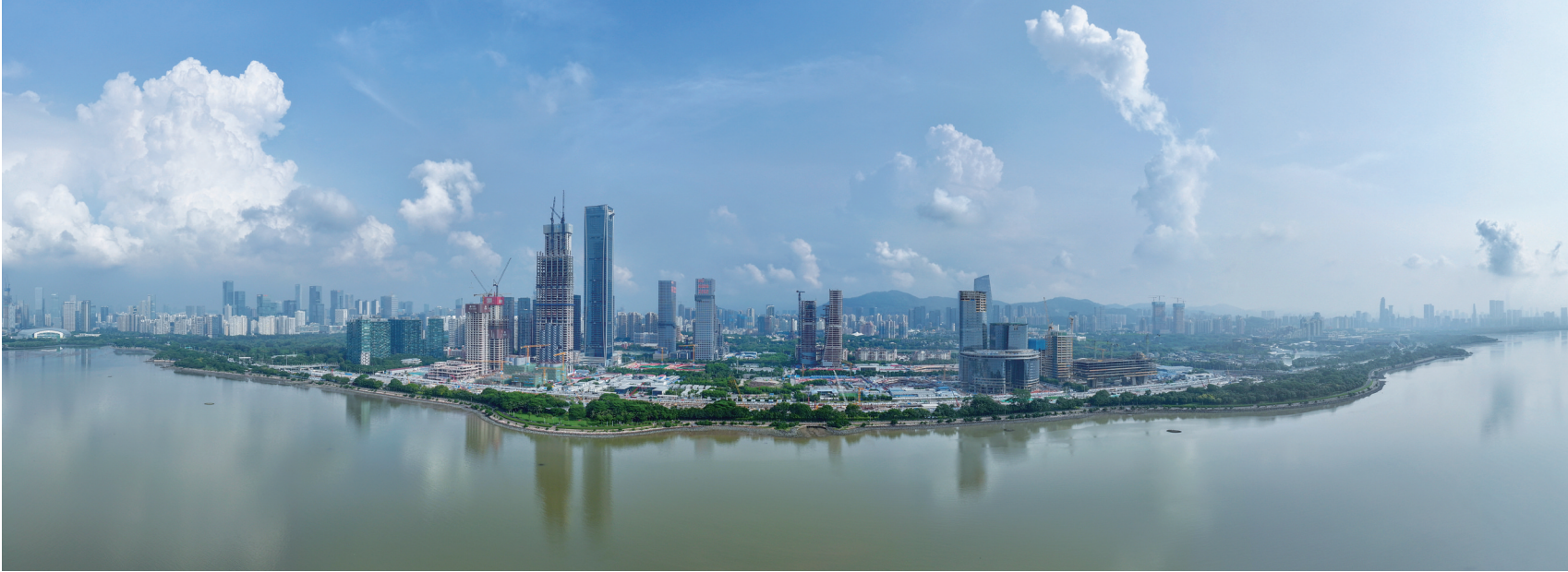
深圳湾超级总部基地是深圳市重点发展区域之一,与香港隔海相望,用地面积117.4万平方米,规划总开发建筑面积约520万平方米,致力于构建集全球总部聚集区、都会文化高地、国际交流中心、世界级滨海客厅为一体的未来城市典范。图为建设中的深圳湾超级总部基地。
