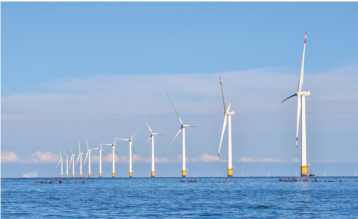
图为大连庄河海上风电项目。
