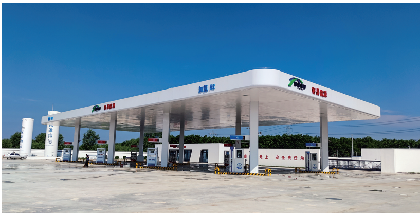
河北省保定市“容易线”综合能源站
