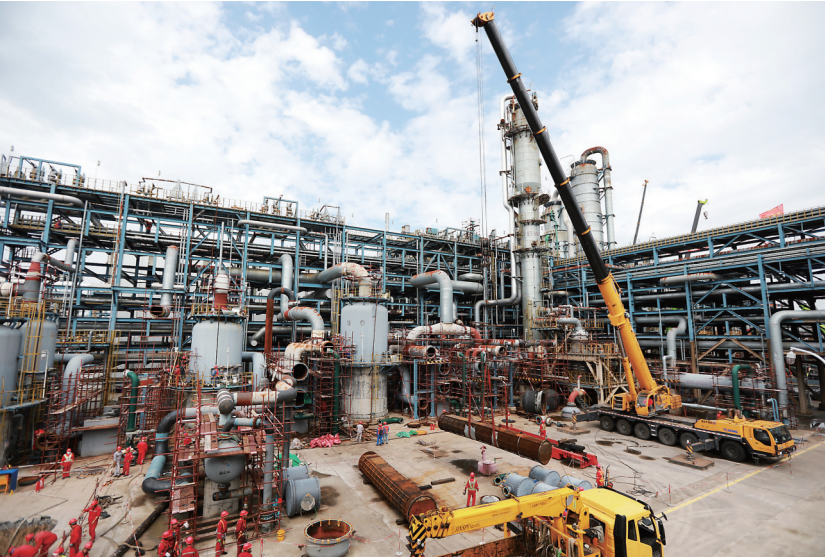
全面管控检修工作标准现场安全质量
