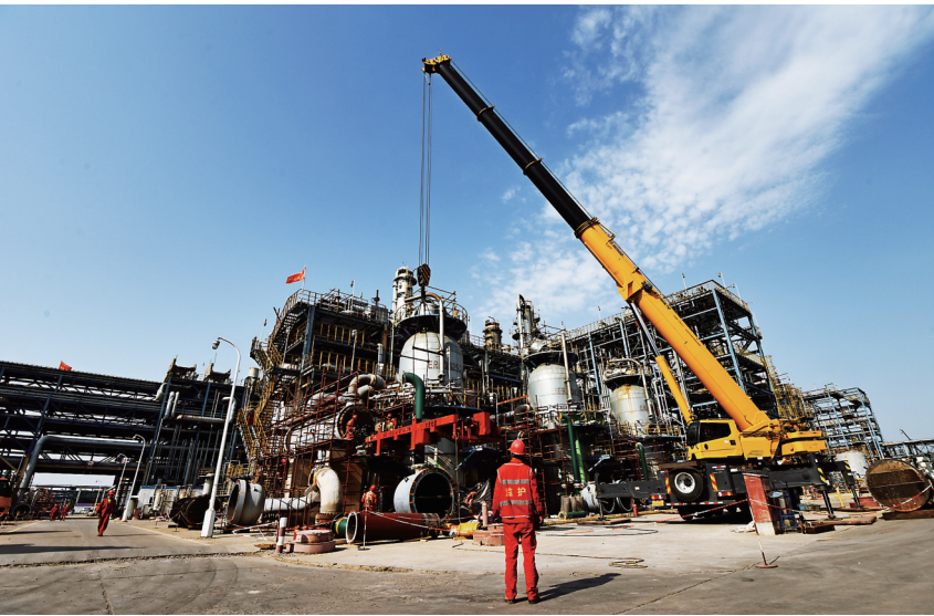
保障装置长周期运行,对检修深度、效率和质量提出高要求
