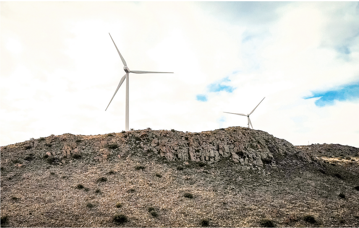
南非自然资源十分丰富,通信、交通、能源等基础设施良好,矿业、制造业、农业和服务业较发达。南非多姿多彩的文化和秀美的自然景观吸引着世界各地的游客。图为在南非北开普省德阿镇拍摄的德阿风电项目风机。
