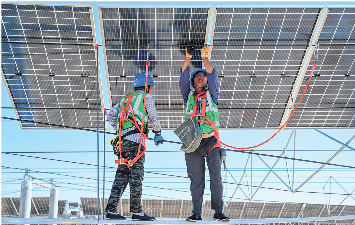
近日，位于内蒙古自治区杭锦旗库布其沙漠亿利生态示范区的蒙西基地库布其200万千瓦光伏治沙项目进入光伏板安装环节。项目预计2024年底前实现全容量并网发电，建成后年平均可供应绿色电力约40亿千瓦时。图为工人在安装光伏板。
