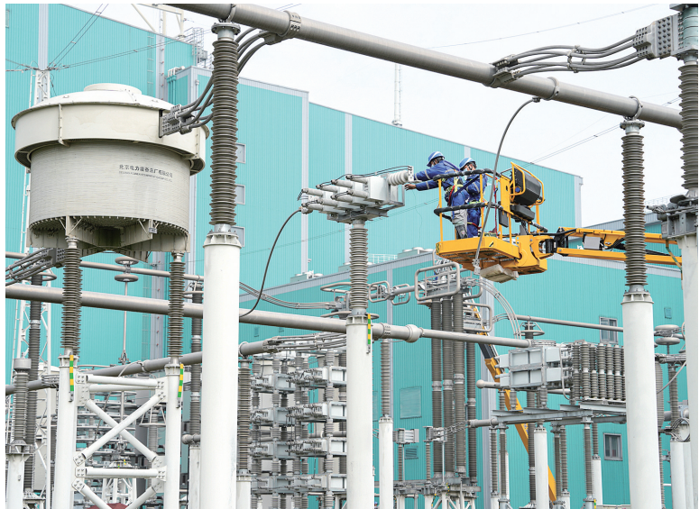
国网安徽电力检修人员对古泉换流站设备进行检修、维护。
