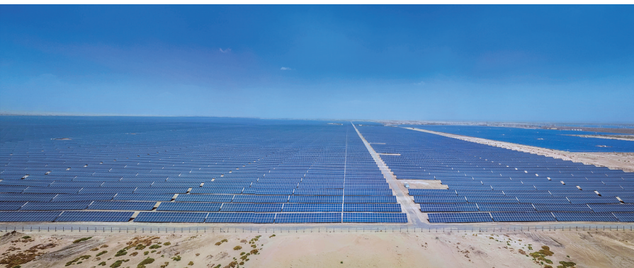
新疆维吾尔自治区阿克苏市阿瓦提县粤水电阿瓦提400MW光伏+储能市场化项目(一道新能源科技股份有限公司供图)
