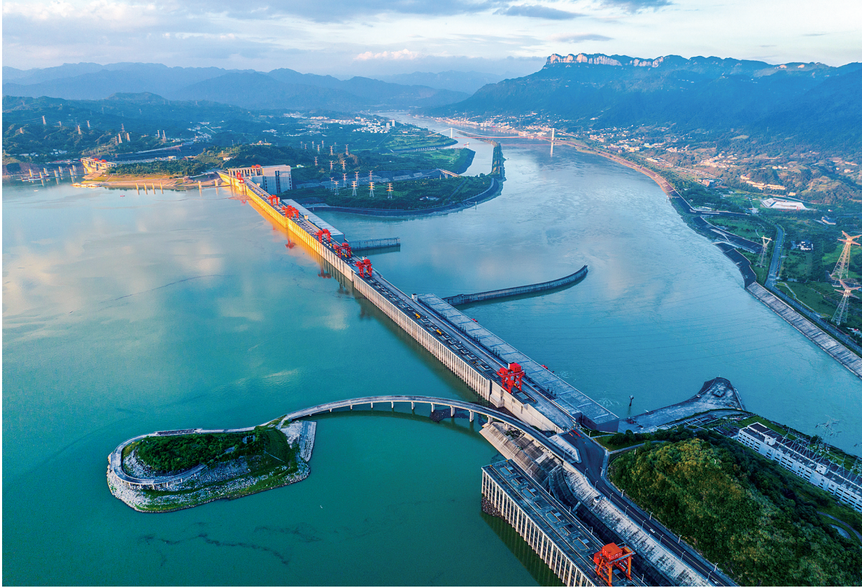
7月10日,三峡电站首台机组投产发电整20年。20年来,三峡电站已累计发出16000多亿千瓦时清洁电能,略高于2022年我国城乡居民生活用电量,相当于替代标准煤4.8亿多吨,减少二氧化碳排放量13.2亿多吨。图为三峡水利枢纽工程。
