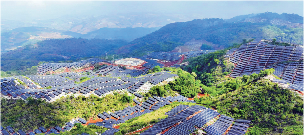
6月29日,国家电投重庆公司习水能源公司负责自主建设的云南省临沧市耿马老东95兆瓦集中式光伏项目实现全容量并网发电。(国家电投供图)
