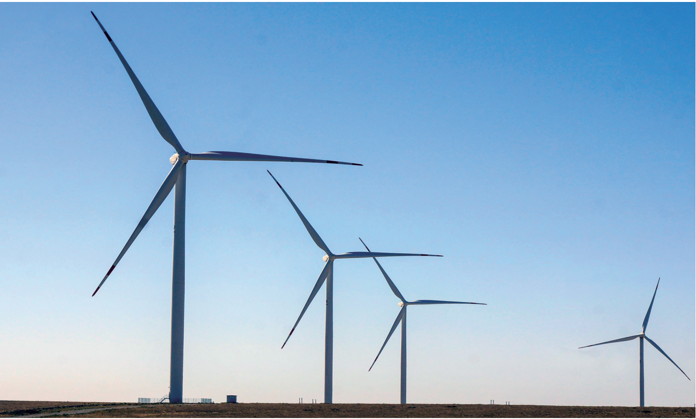
哈萨克斯坦札纳塔斯100兆瓦风电项目
