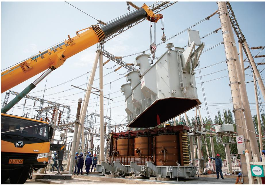
近日,国网银川供电公司变电检修人员对连续运行27年的掌政220千伏变电站1号主变压器进行大修,确保迎峰度夏期间银川电网安全可靠运行。图为电力工人在工程现场进行检修作业。新华社记者 王鹏 摄
