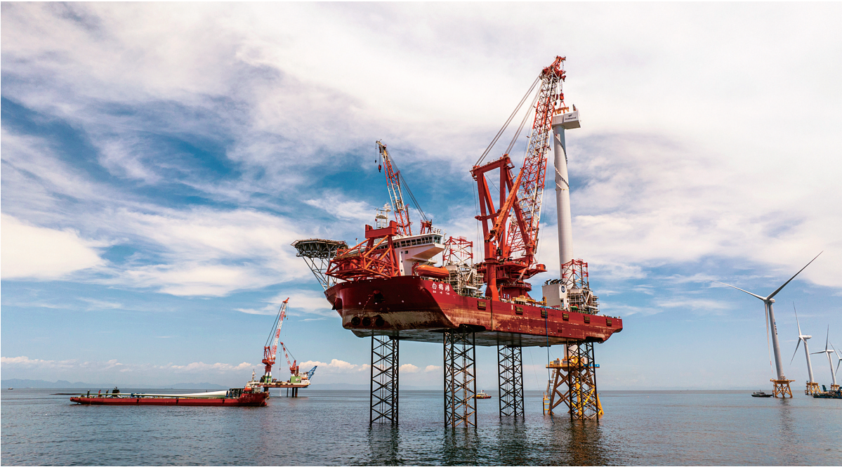
6 月 28 日,全球首台 16 兆瓦海上风电机组在福建省福州市平潭三峡海上风电场成功完成吊装。(三峡集团供图)
