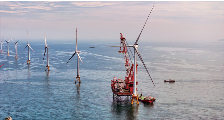
全球首台 16 兆瓦海上风电机组吊装现场 (三峡集团供图)
