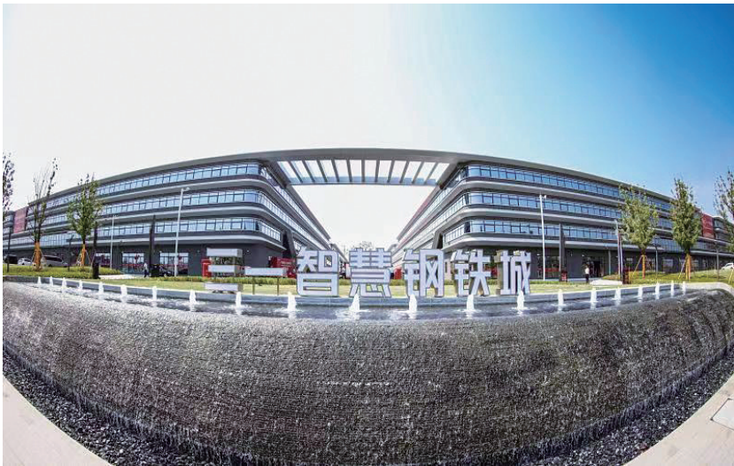
株洲三一智慧钢铁城项目
