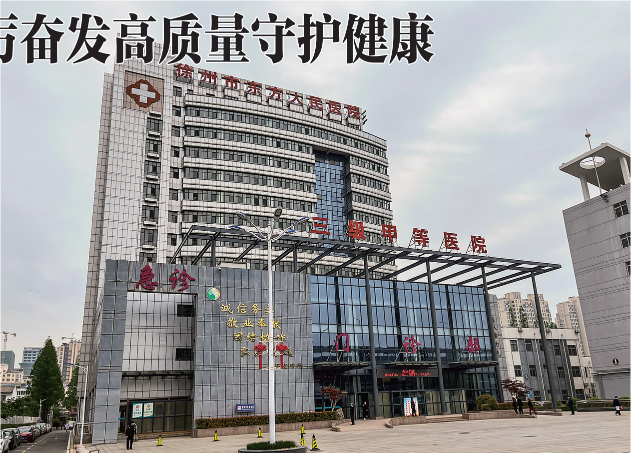
徐州市东方人民医院门诊大楼全貌
