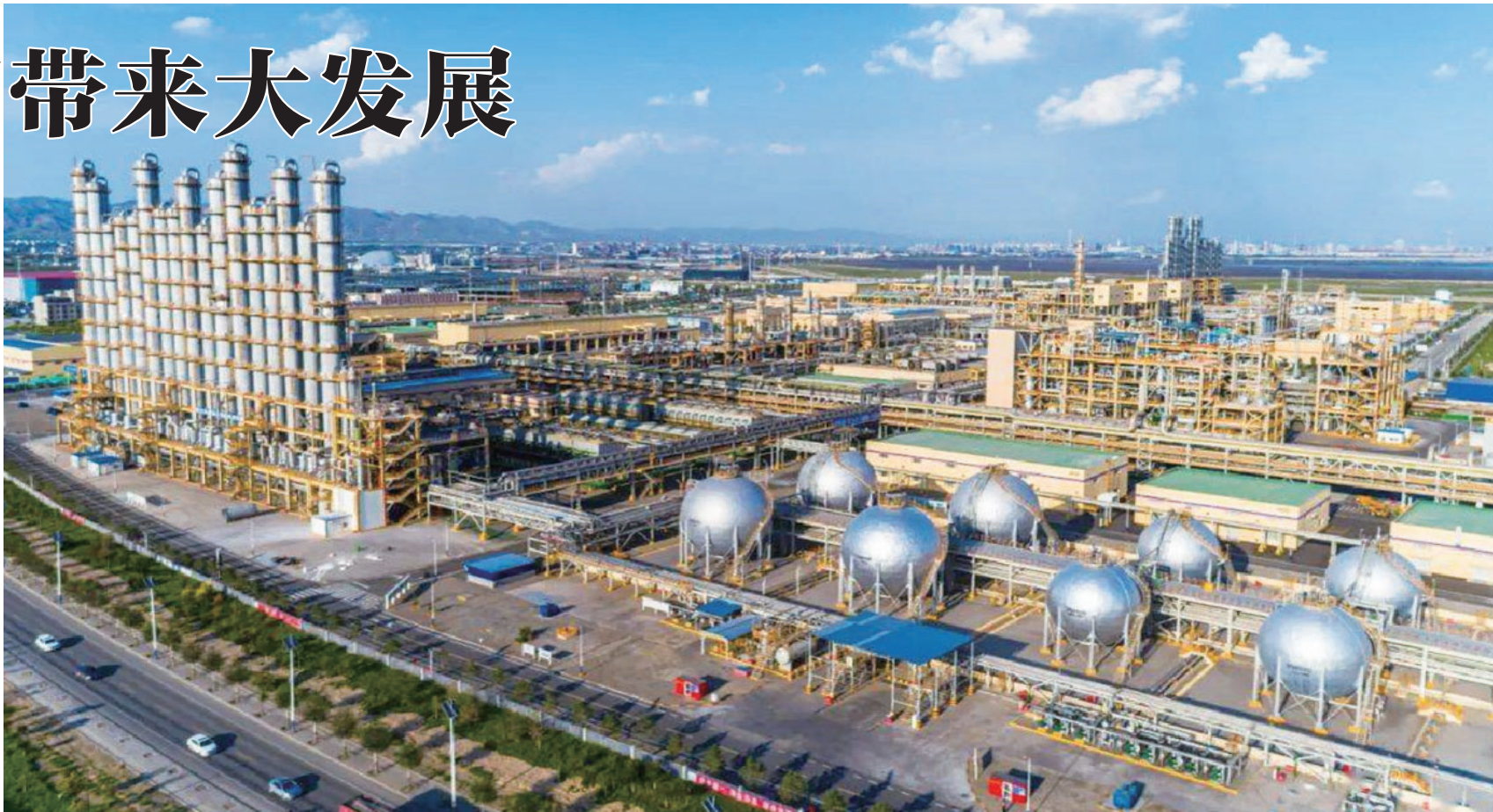
包头市硅产业招商引资、项目建设成果丰硕。图为通威高纯晶硅项目全景。
