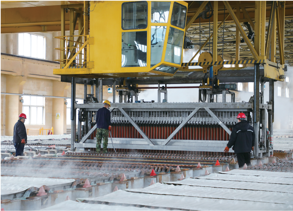
工人们正在中冶葫芦岛有色金属集团有限公司的电解铜厂内忙碌工作。 (中冶葫芦岛有色金属集团有限公司供图)
