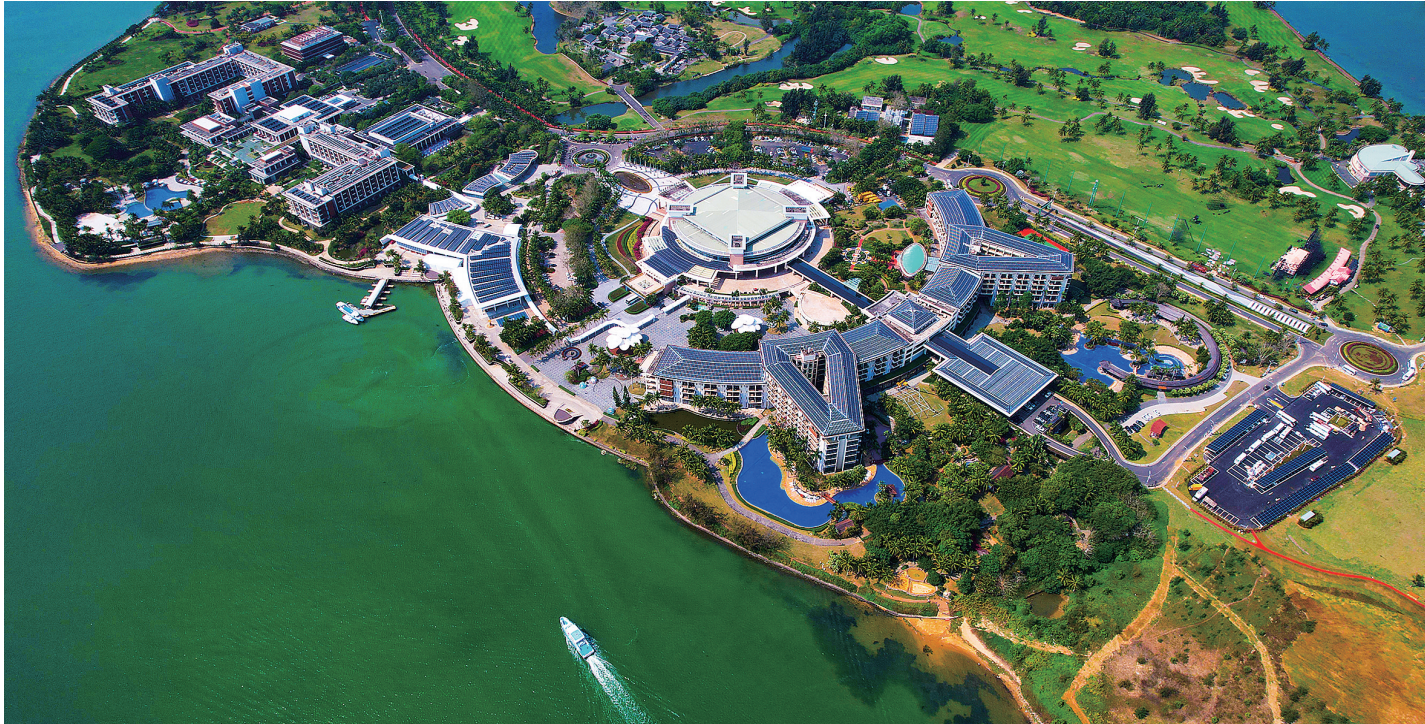
博鳌亚洲论坛2023年年会突出“双碳”理念,重点关注绿色发展与能源议题,在新能源生产和规模化应用、新能源汽车、绿色供应链以及储能技术等方面推行系列举措,践行“双碳”理念。图为在博鳌零碳示范区大部分建筑屋顶上都铺设了光伏板。新华社记者 杨冠宇 摄
