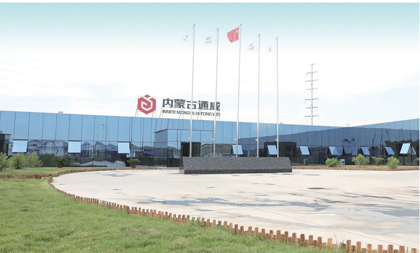
内蒙古通威高纯晶硅二期项目部
