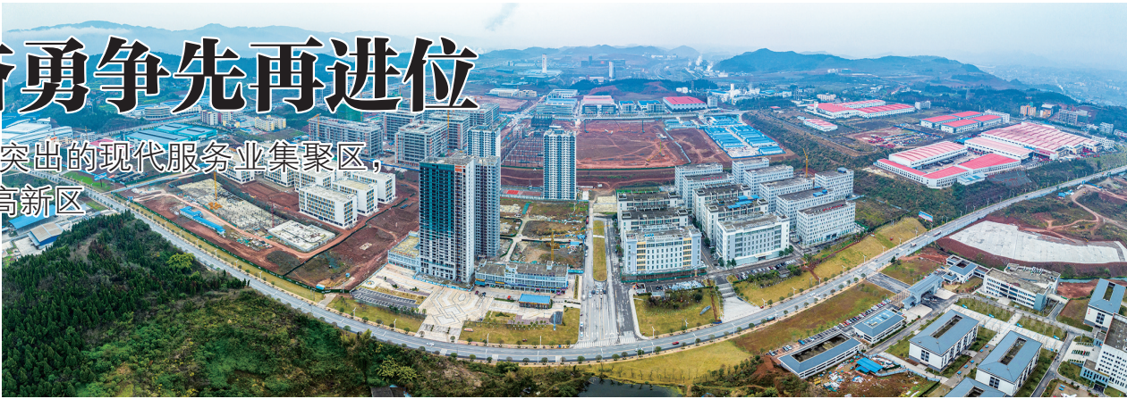
达州高新区电子信息产业园
